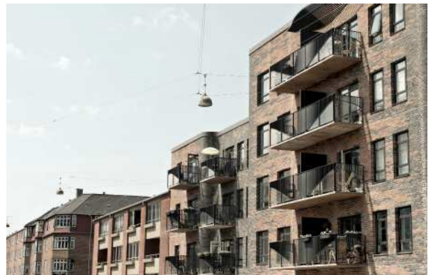
'Hebsgårds Have'. 60 nye Ældreboliger, Vanløse.
