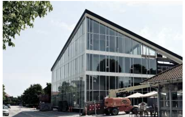
Shopping center i Herlev. Om og tilbygning.
